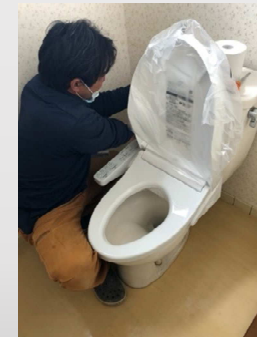
某社 渋川事業所様 トイレ入替工事
