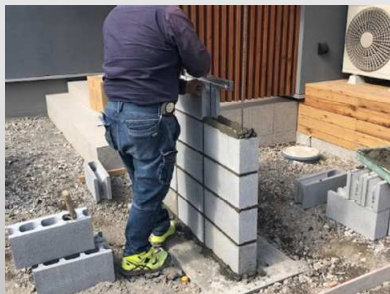
高崎市 S 様邸 外構工事
